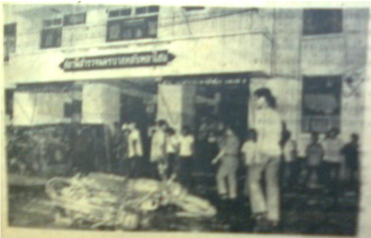
ความเสียหายบริเวณสถานีตำรวจพลับพลายไชย ชาวไทย , 6 กรกฎาคม 2517.
